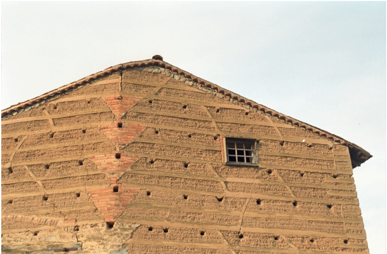
Débats-Rivière-d'Orpra, Ligeay, grange (1987 A1 712). Détail du pignon : chaînage en brique.
