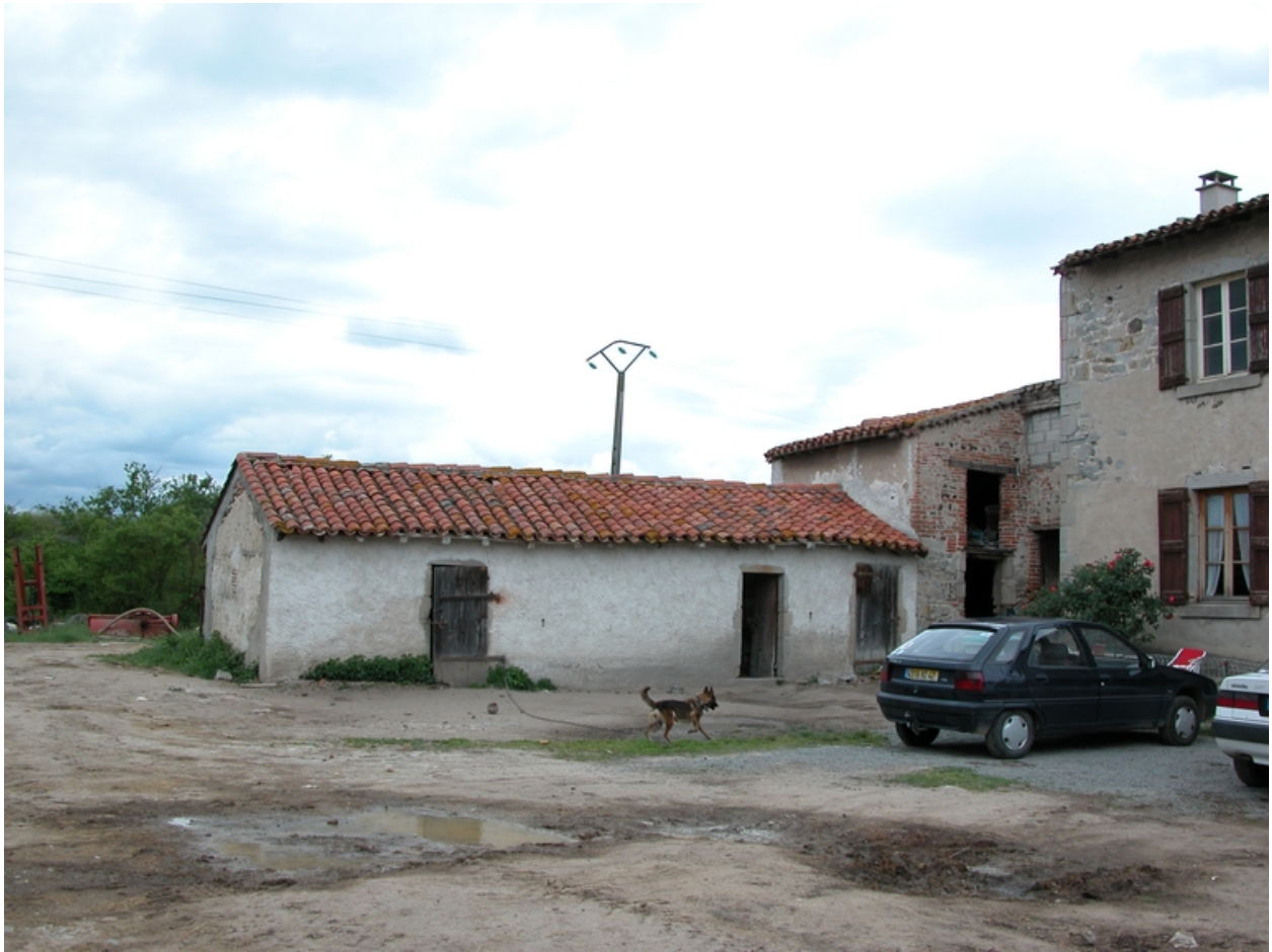
Vue des remises et de la porcherie en retour du logis.
