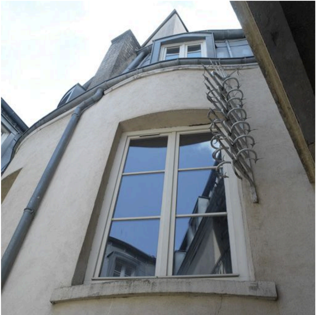
Première cour, dernier étage du corps de liaison sud et artichaut du repos de l'escalier
