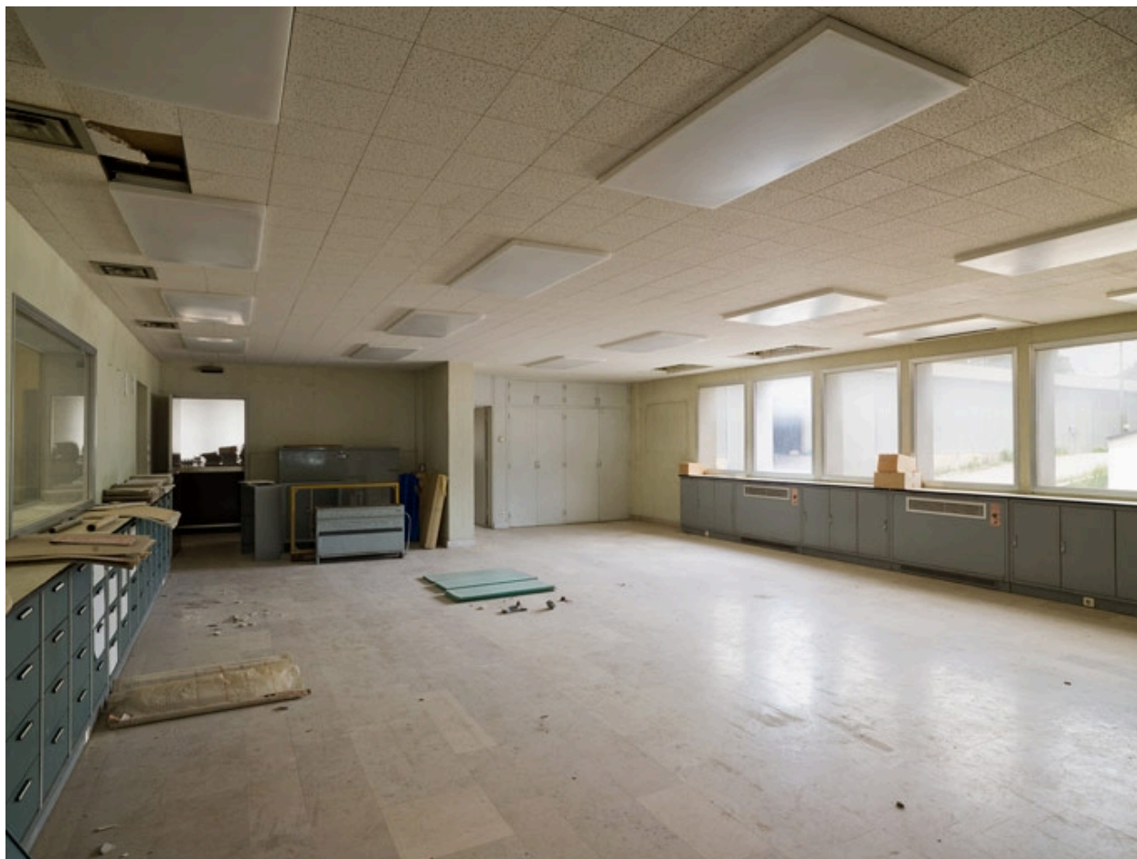
Vue intérieure des bureaux : 1er étage
