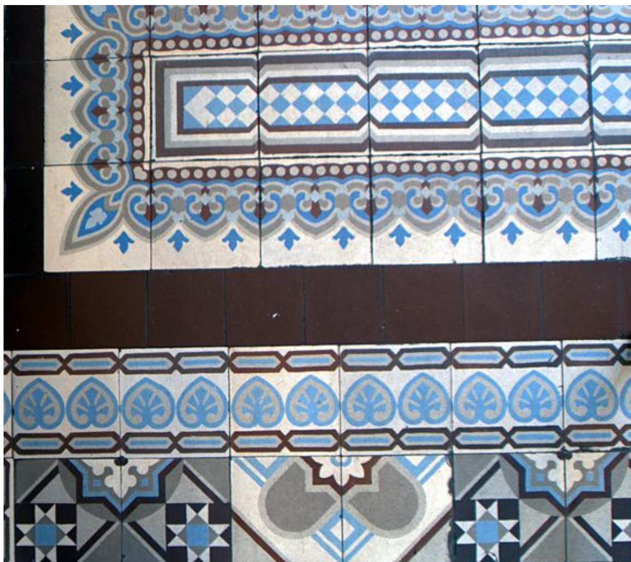
Carrelage en carreaux de ciment, vestibule
