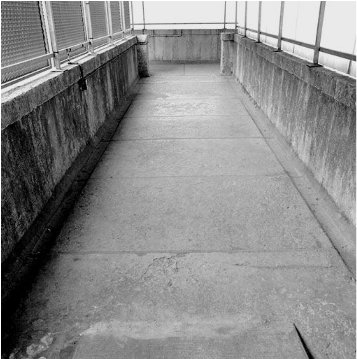
Premier étage, partie nord : la galerie
