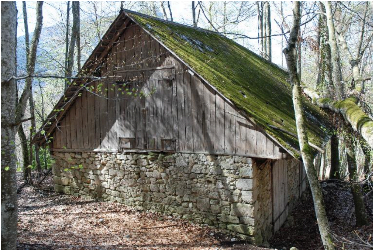
Vue du mur pignon amont.
