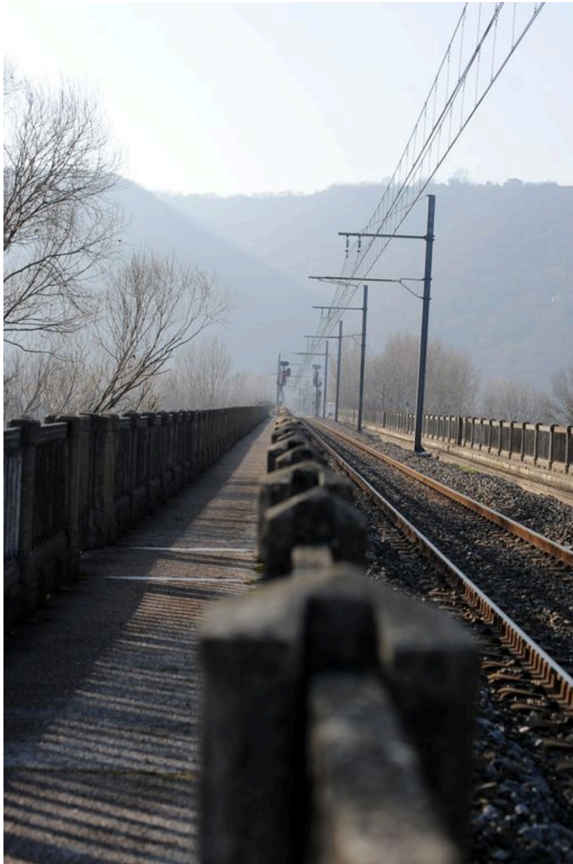
Vue générale, de dessus, voies ferrée et piétonne (depuis la rive gauche)
