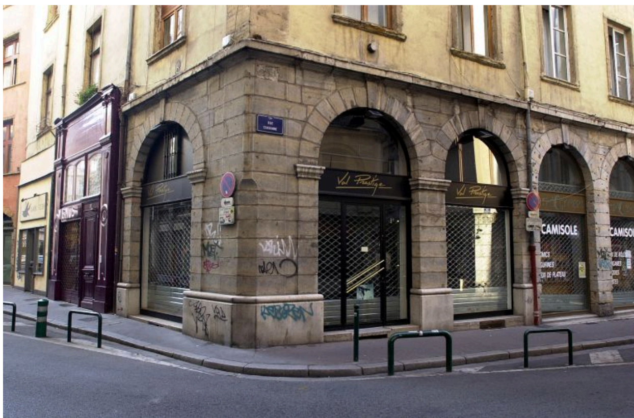
Façade nord sur la rue Chavanne, rez-de-chaussée
