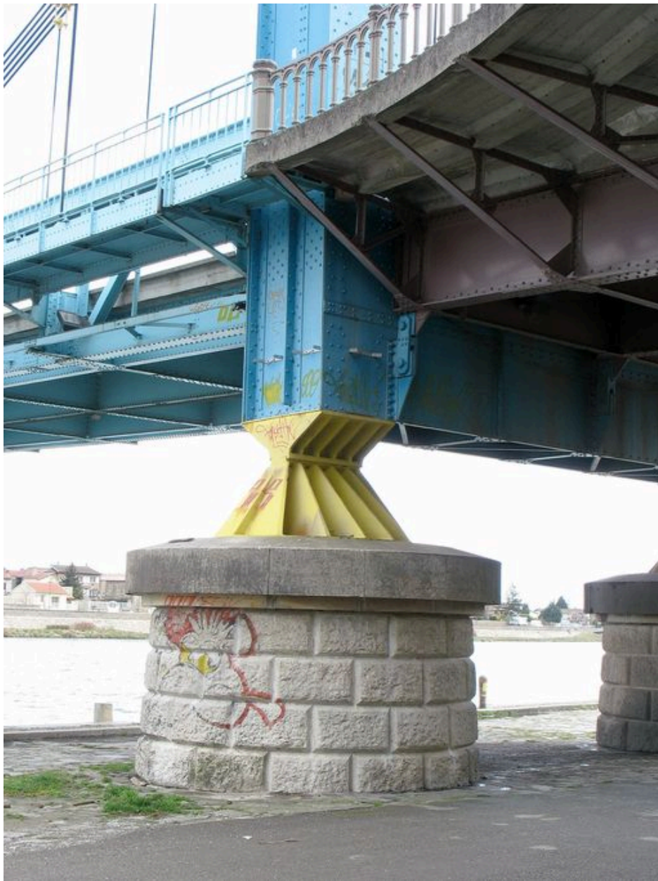
Rive droite, partie inférieure du pylône : vue d'un socle
