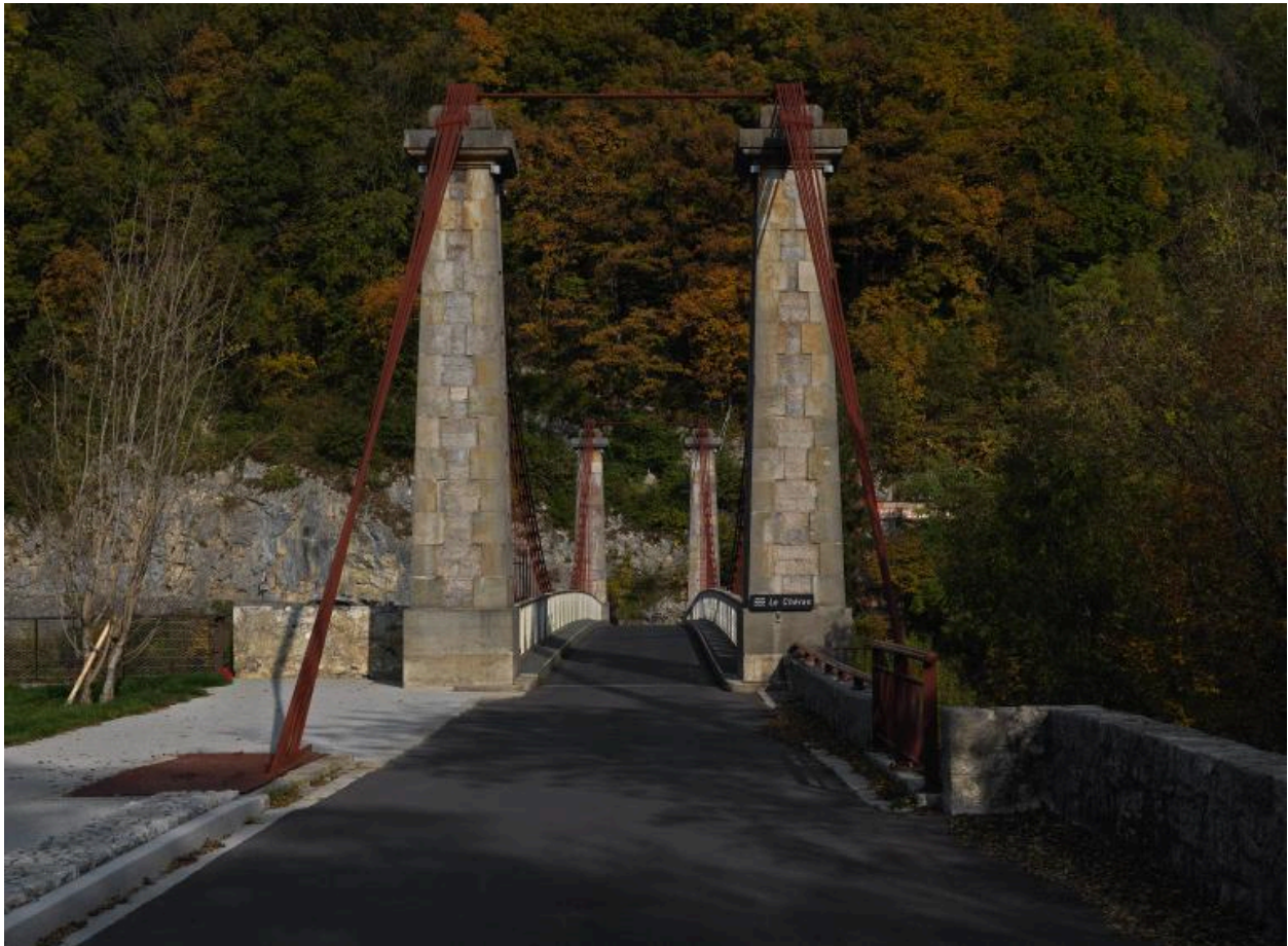
Vue d'ensemble du tablier du pont et des piliers en enfilade, prise depuis Cusy.
