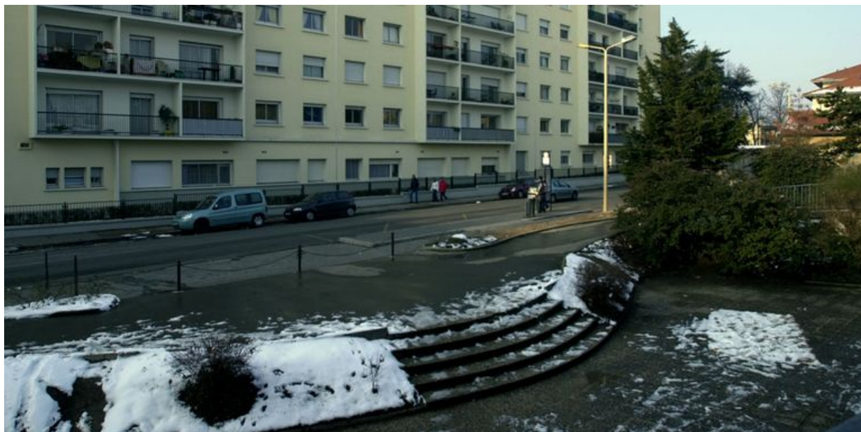
Vue de l'emmarchement du parvis
