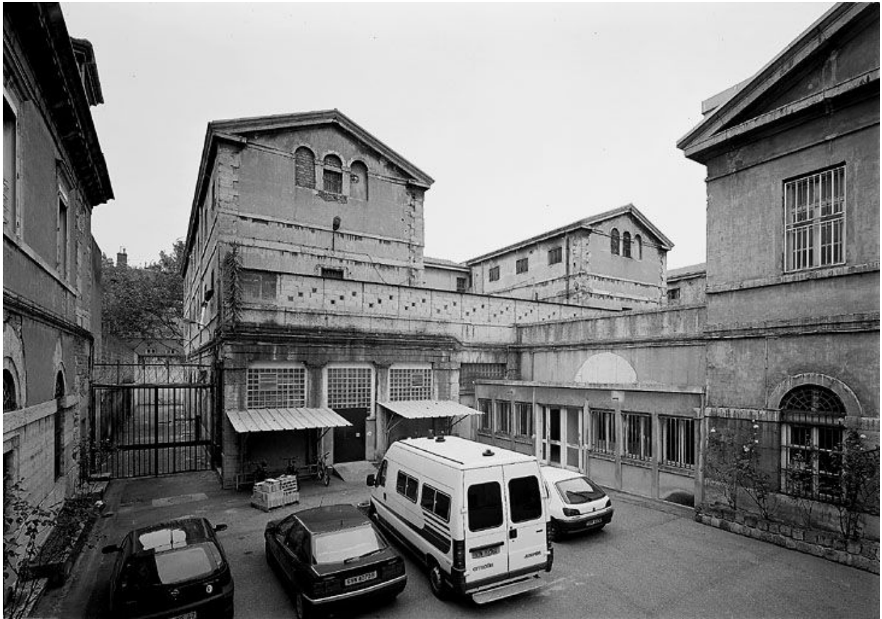
Angle sud-ouest de la cour d'honneur
