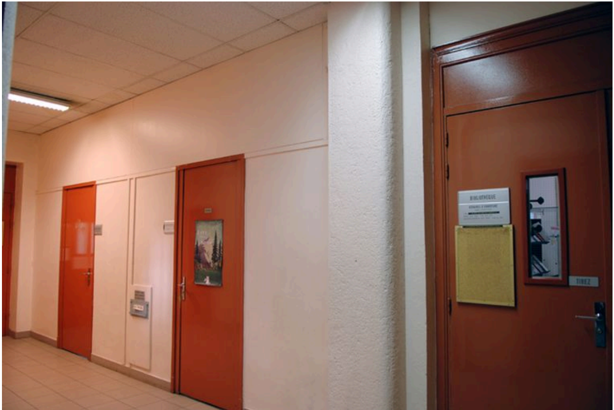
1er étage, couloir d'accès à la bibliothèque
