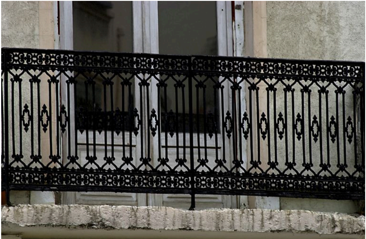
Détail du garde-corps du balcon
