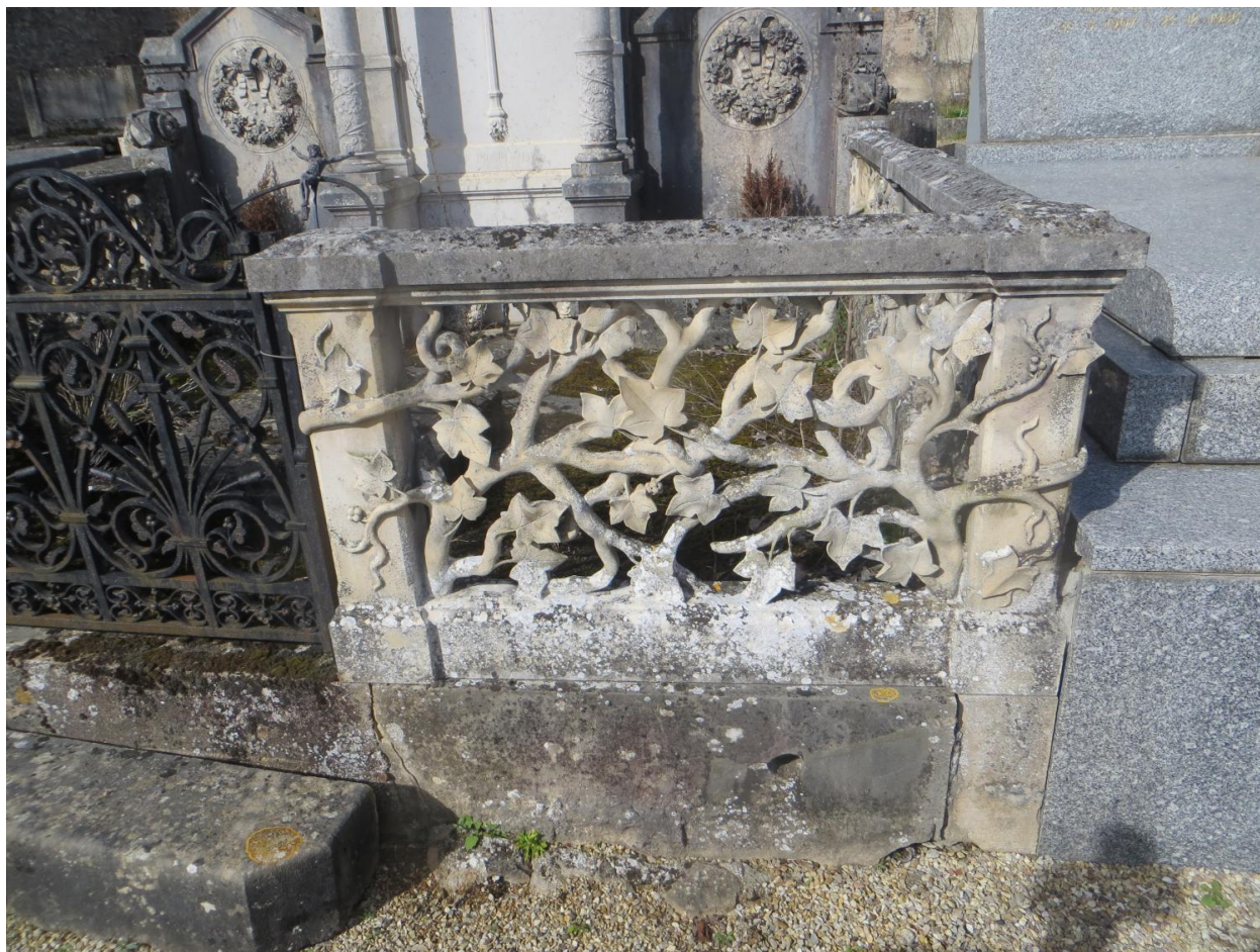
Clôture : partie droite
