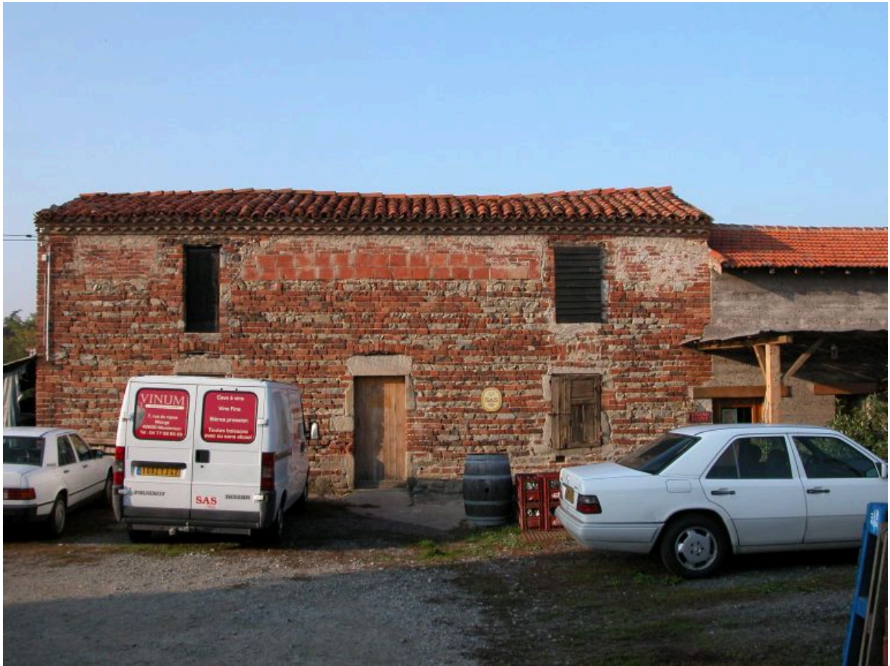
Vue d'ensemble de face du bâtiment abritant le cuvage.
