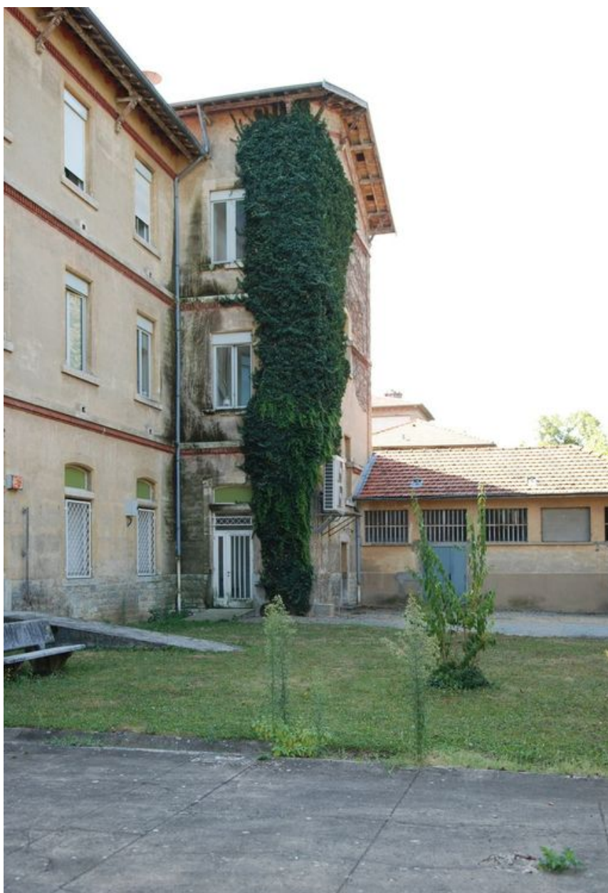
Façade postérieure (ouest) depuis le nord-ouest
