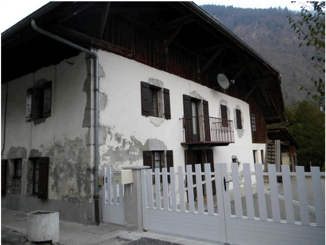
Vue du mur pignon sud.
