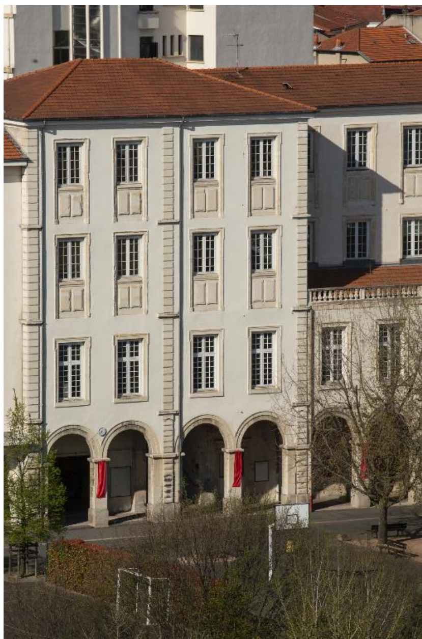
Bâtiment H. Travée d'entrée
