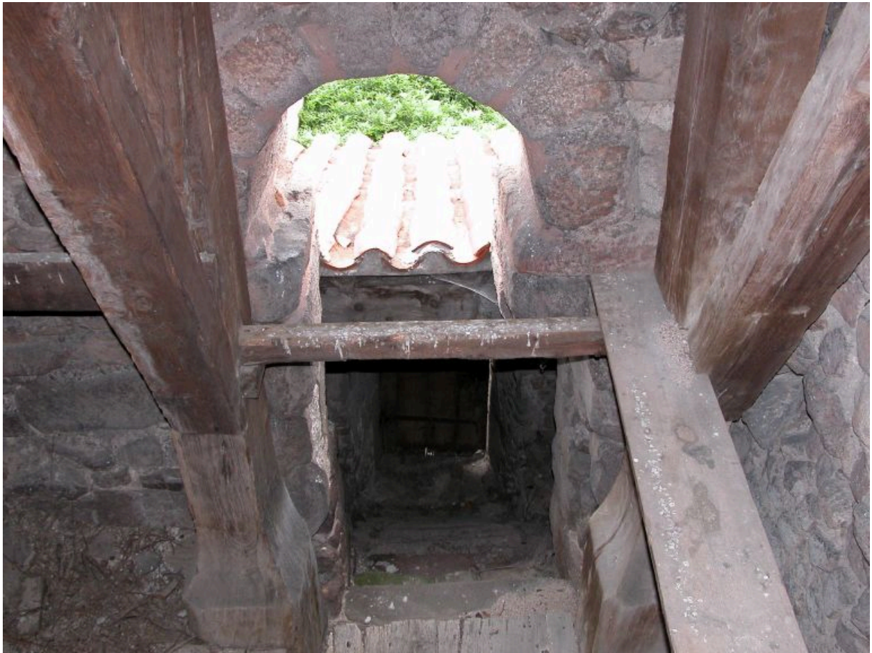
Montée d'escalier intérieur conduisant au clocher, vue depuis le haut.
