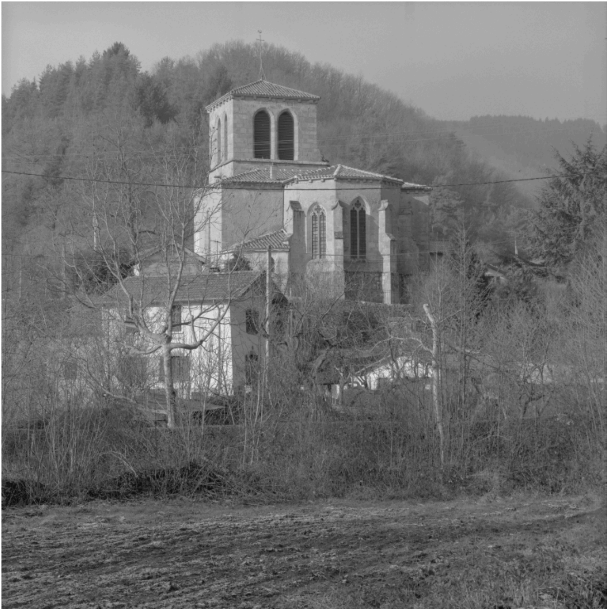
Vue d'ensemble de l'église depuis l'est.
