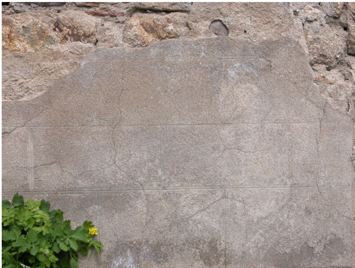
Détail de l'enduit du mur de clôture.
