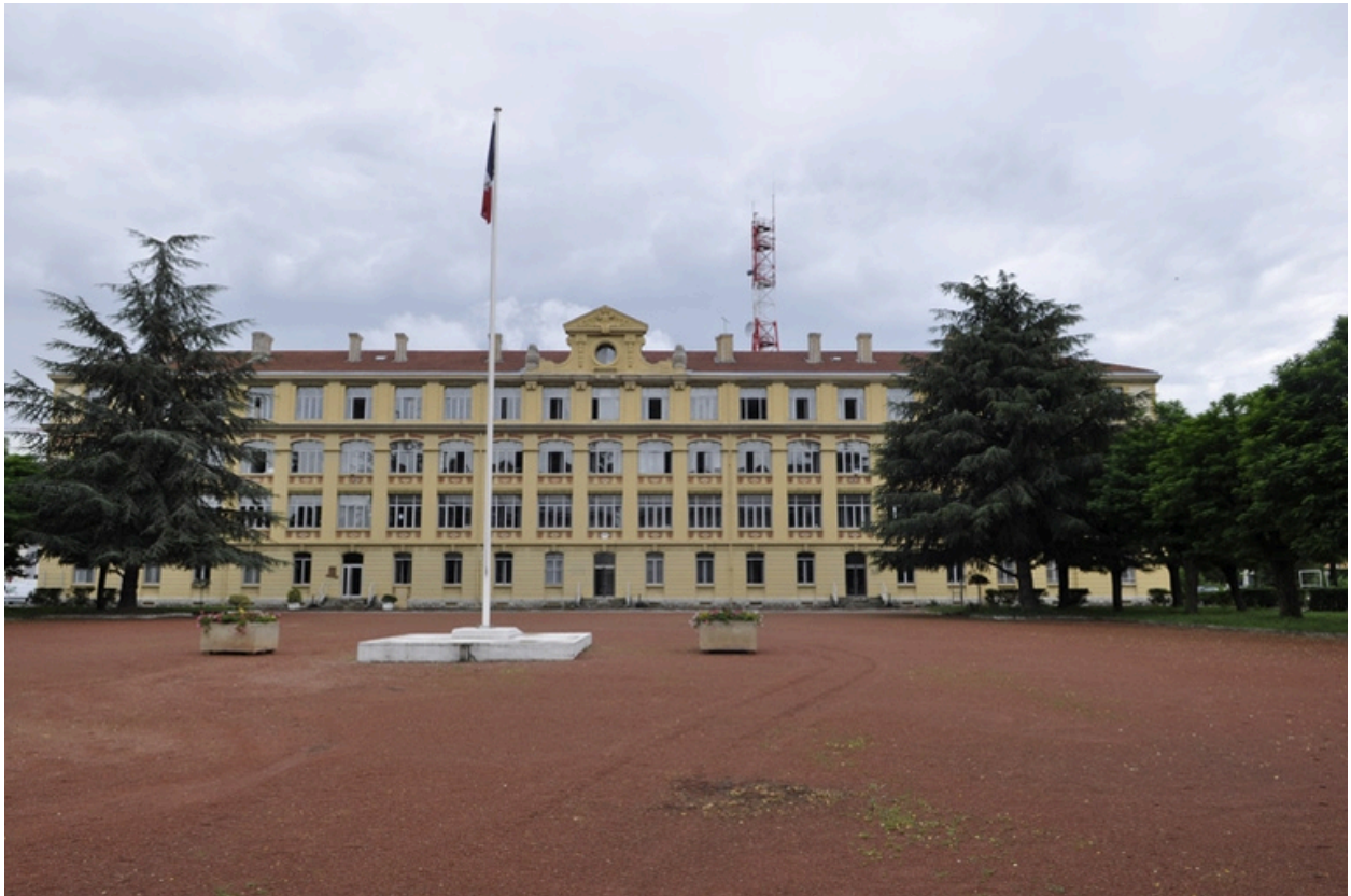
Place d'armes et bâtiment de 1916, façade nord.
