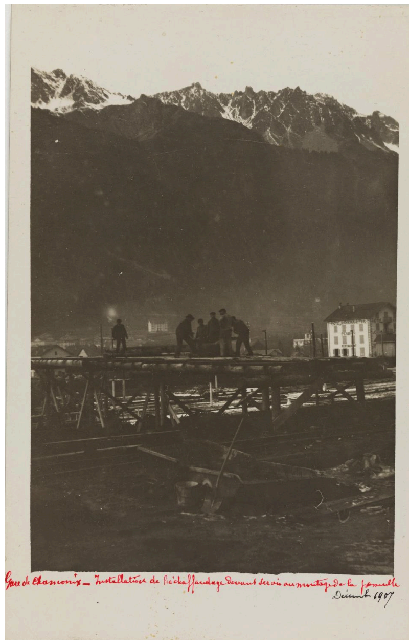
Gare de Chamonix, Installation de l'échafaudage. 1907 (AD Haute-Savoie : 36 Fi 534)
