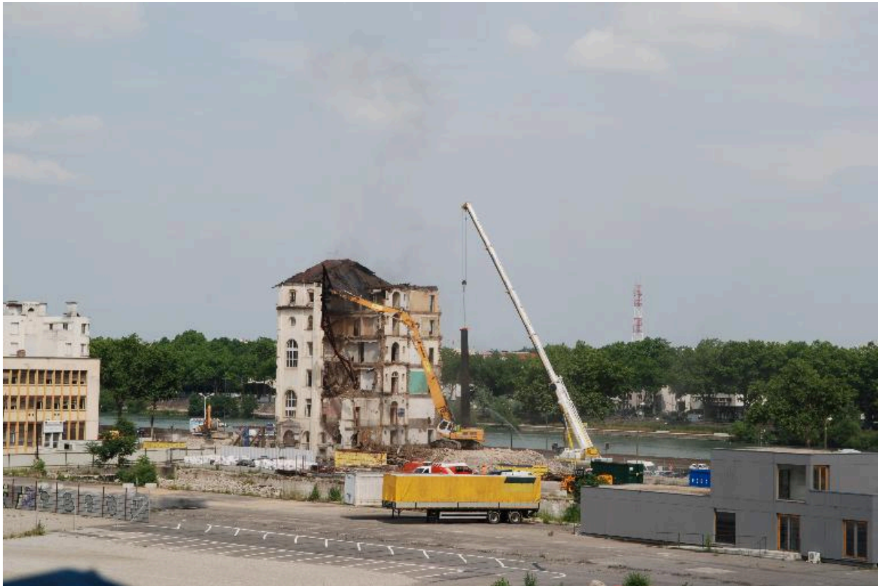
L'immeuble en cours de démolition
