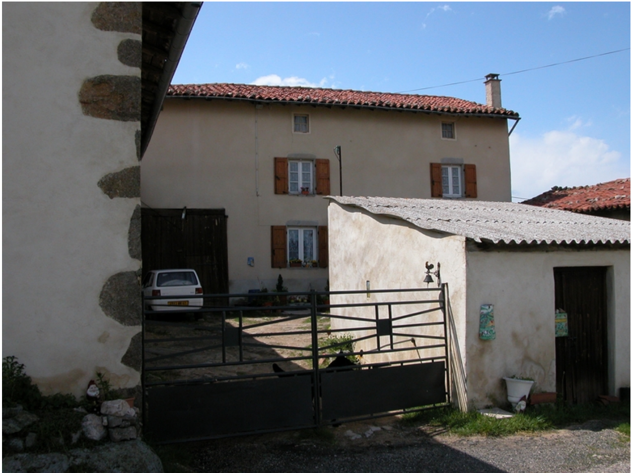
Vue d'ensemble depuis l'entrée de la cour.
