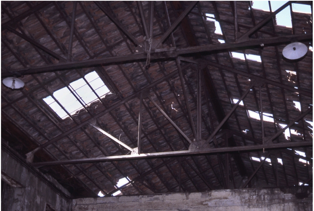
charpente métallique dans annexe de la cartoucherie
