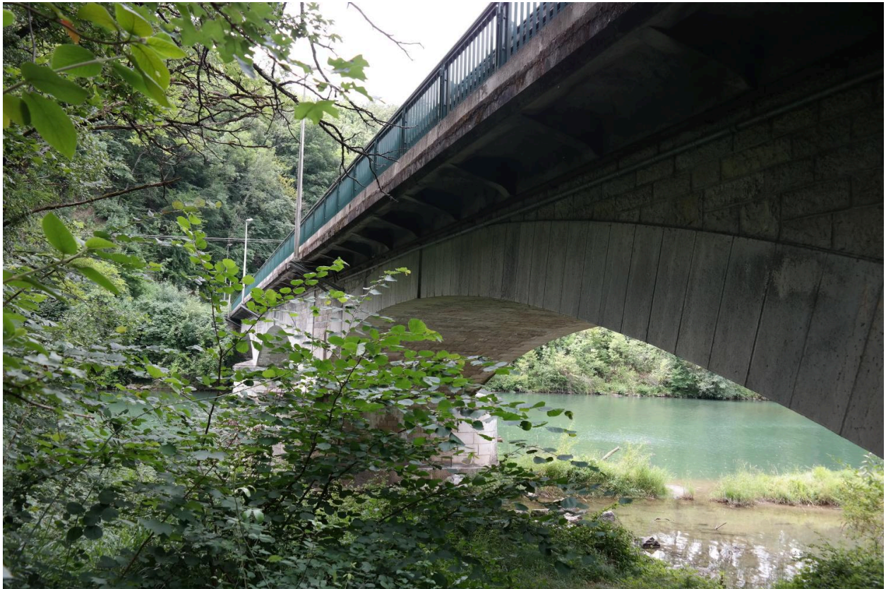
Pont du Fier. Détail de l'élargissement du tablier.
