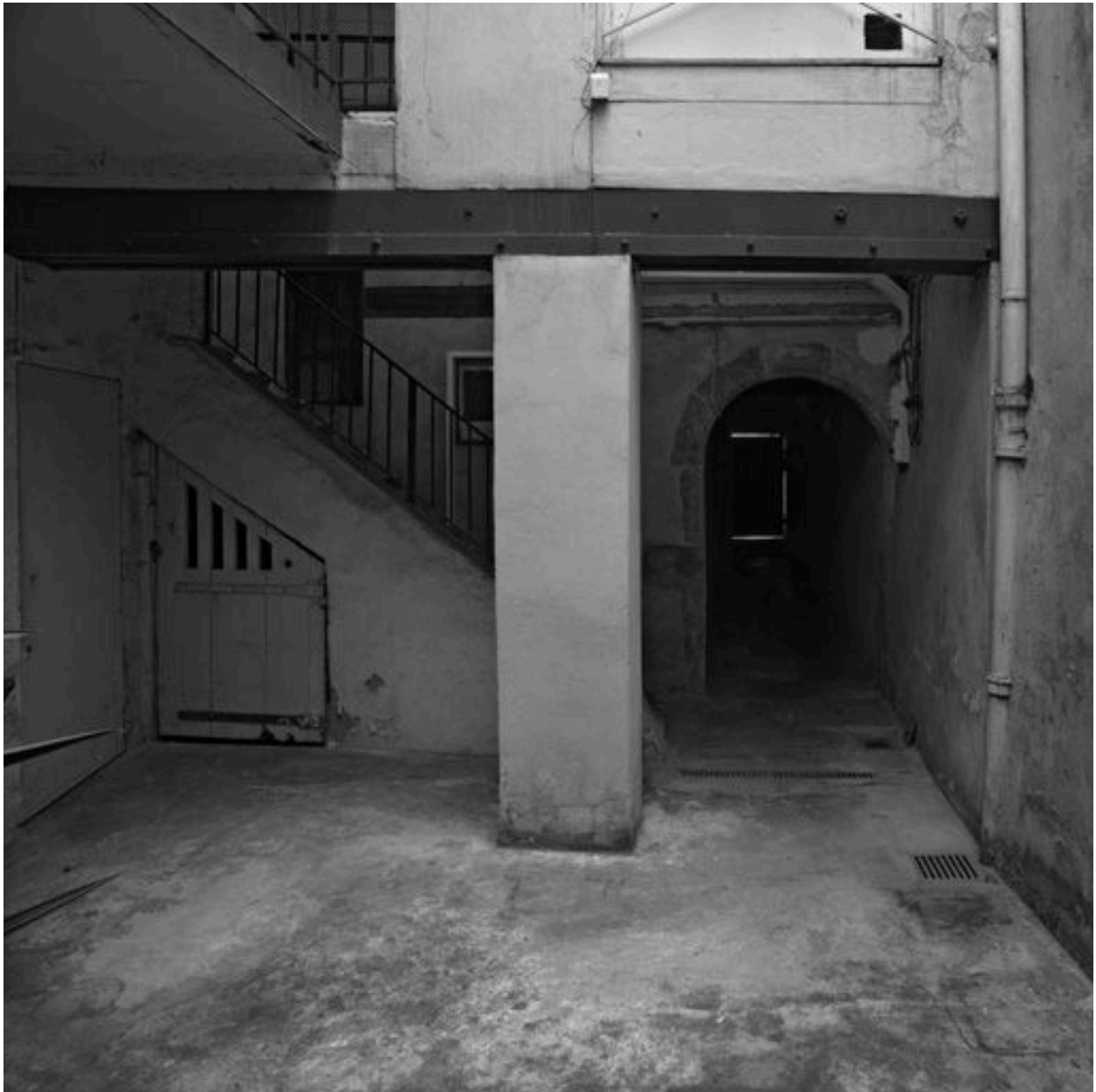
Vue du vestibule et du départ de l'escalier depuis le fond de la cour
