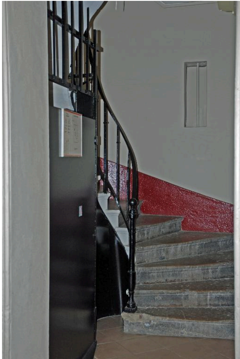
Immeuble sur cour : vue du départ de l'escalier
