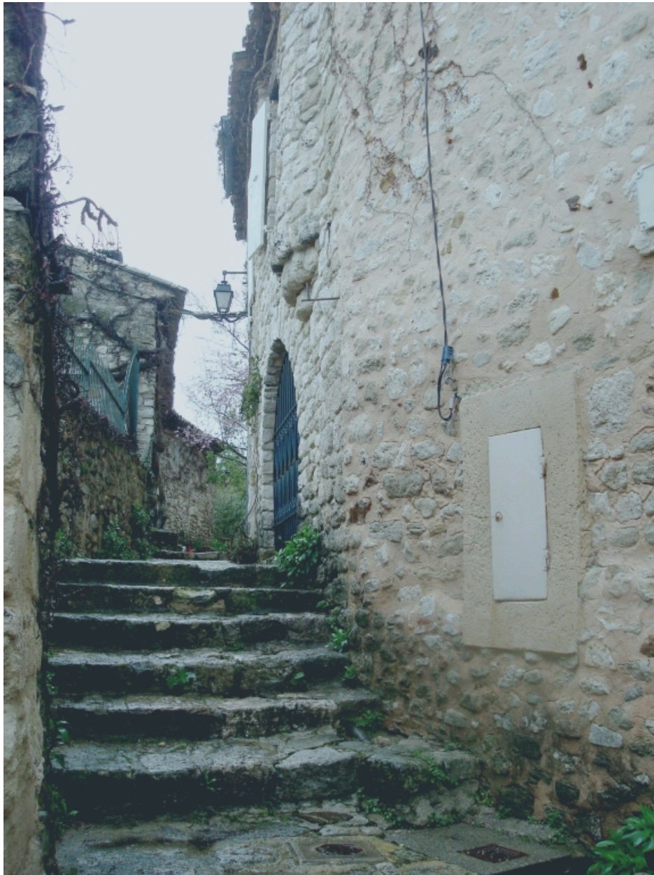
Sente du Potier, élévation d'une maison présentant un encorbellement sur cul-de-lampe à ressauts.
