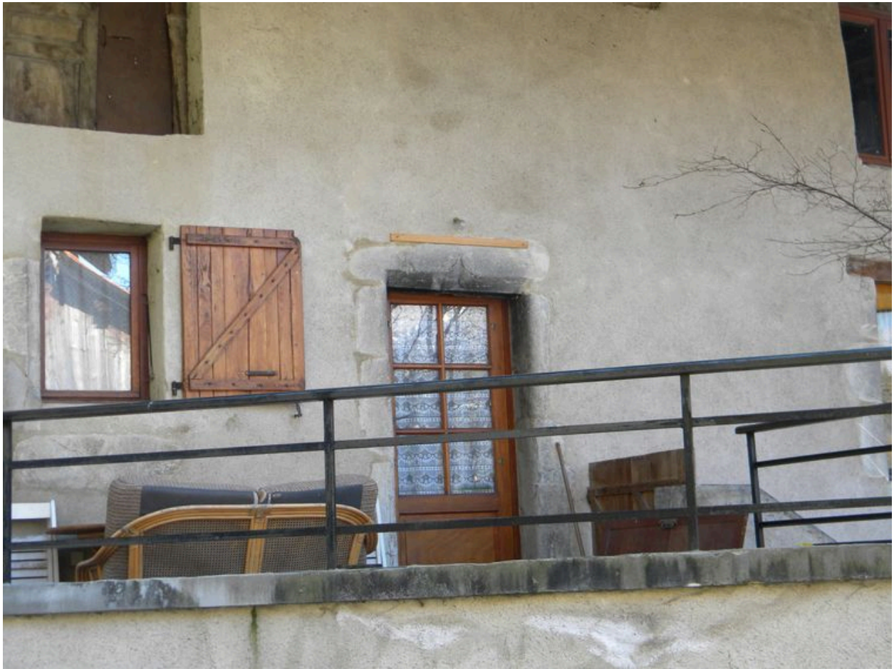
porte à accolade sur une ancienne ferme au couer du hameau (A3 965, 966)
