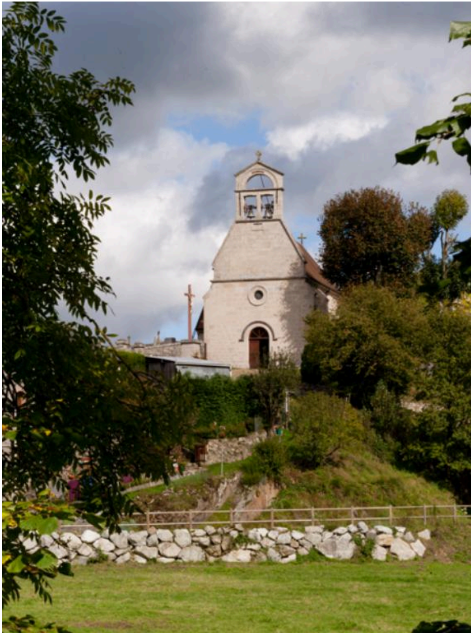
Vue générale de la façade occidentale.
