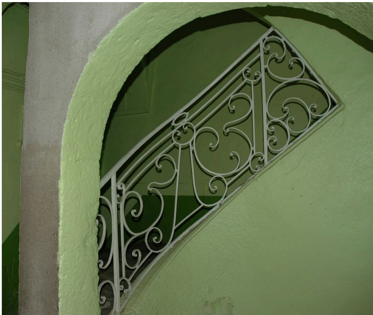
Détail, garde-corps en ferronnerie.
