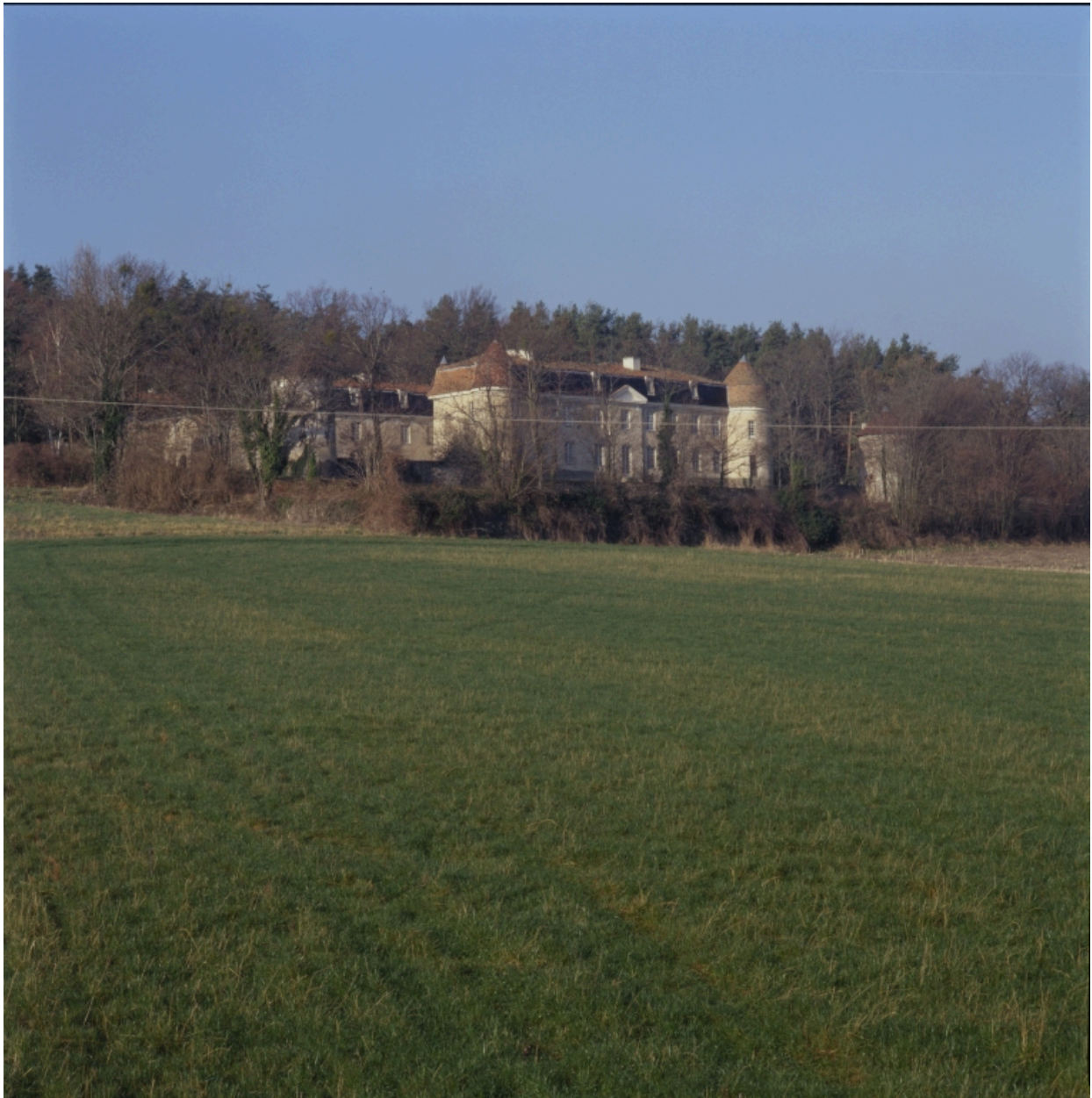
Vue d'ensemble du château depuis la route en contrebas, de l'est.
