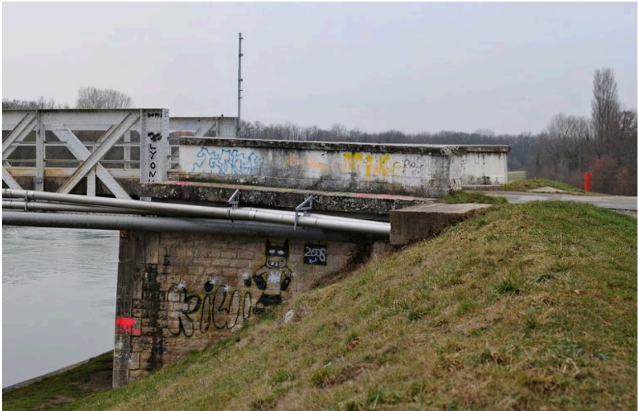
Culée droite, face amont, vue générale (depuis la rive droite)
