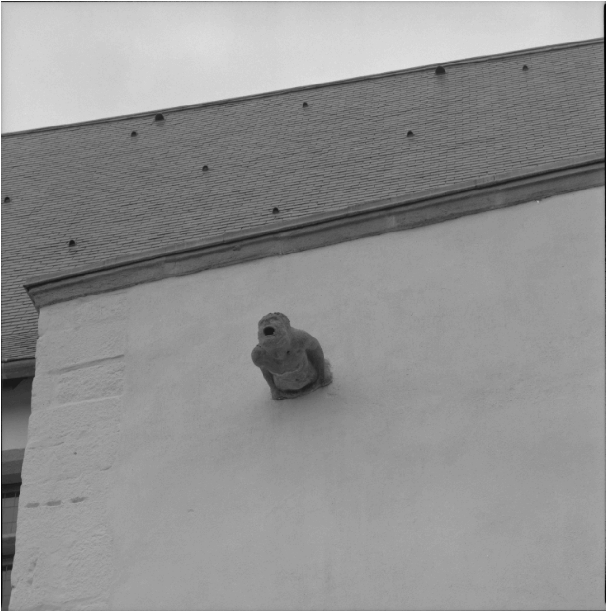
Façade sur jardin du bastion sud-est : détail d'une gargouille.
