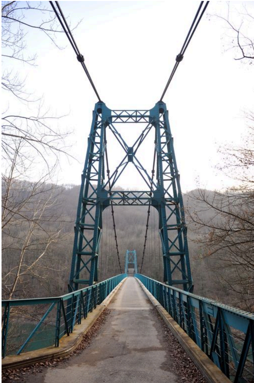
Vue générale, de dessus, chaussée et pylônes (depuis la rive droite)
