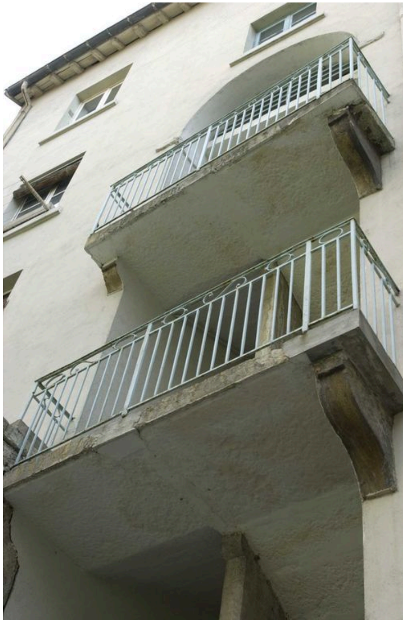
Vue des balcons sur cour
