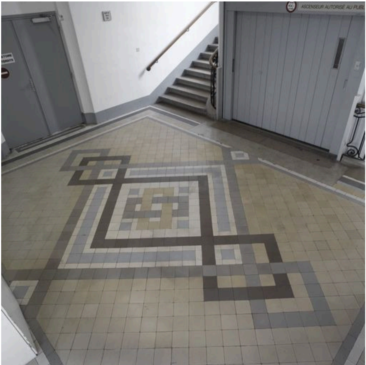
Bâtiment B, partie sud, sol du palier et escalier secondaire
