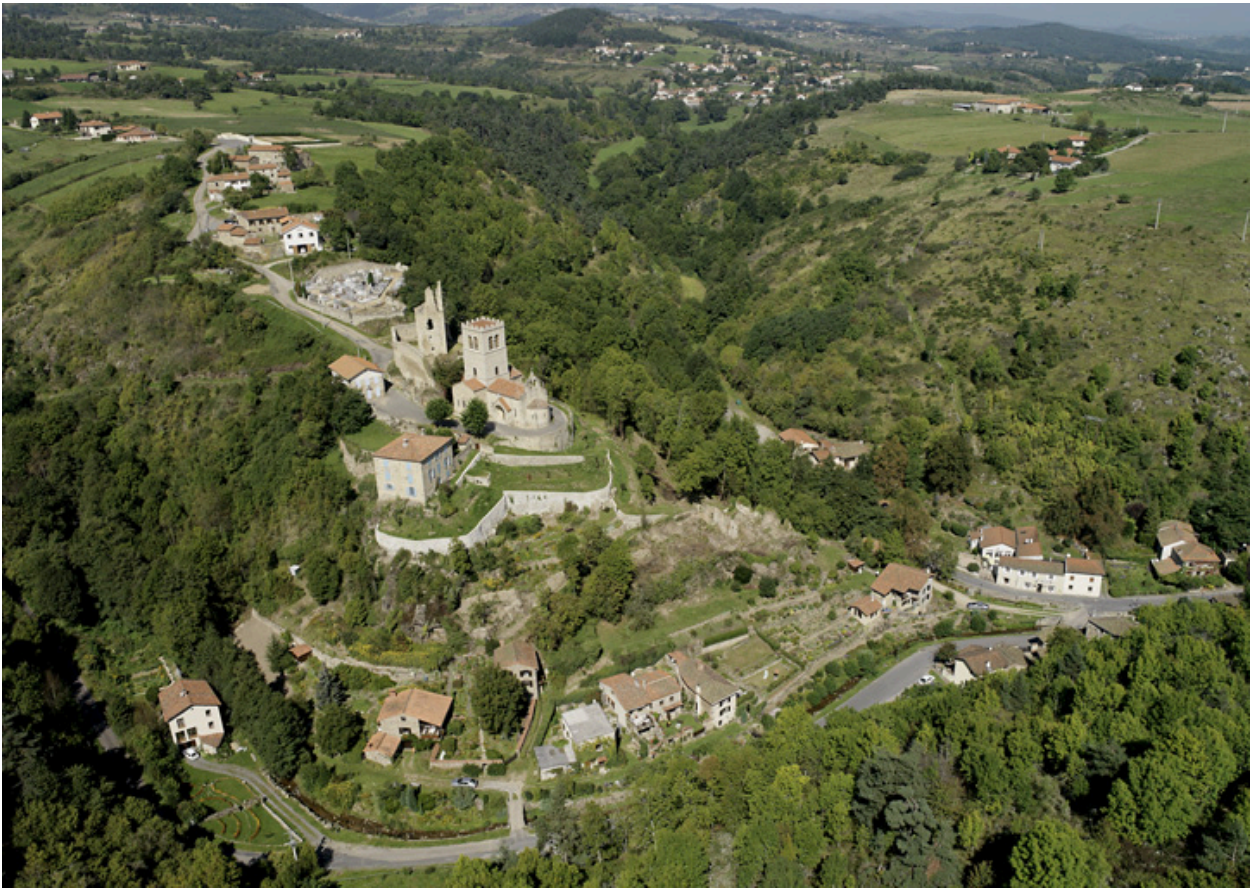
Vue générale aérienne du site du Vieil Écotay et du Taillou, depuis le sud-est.
