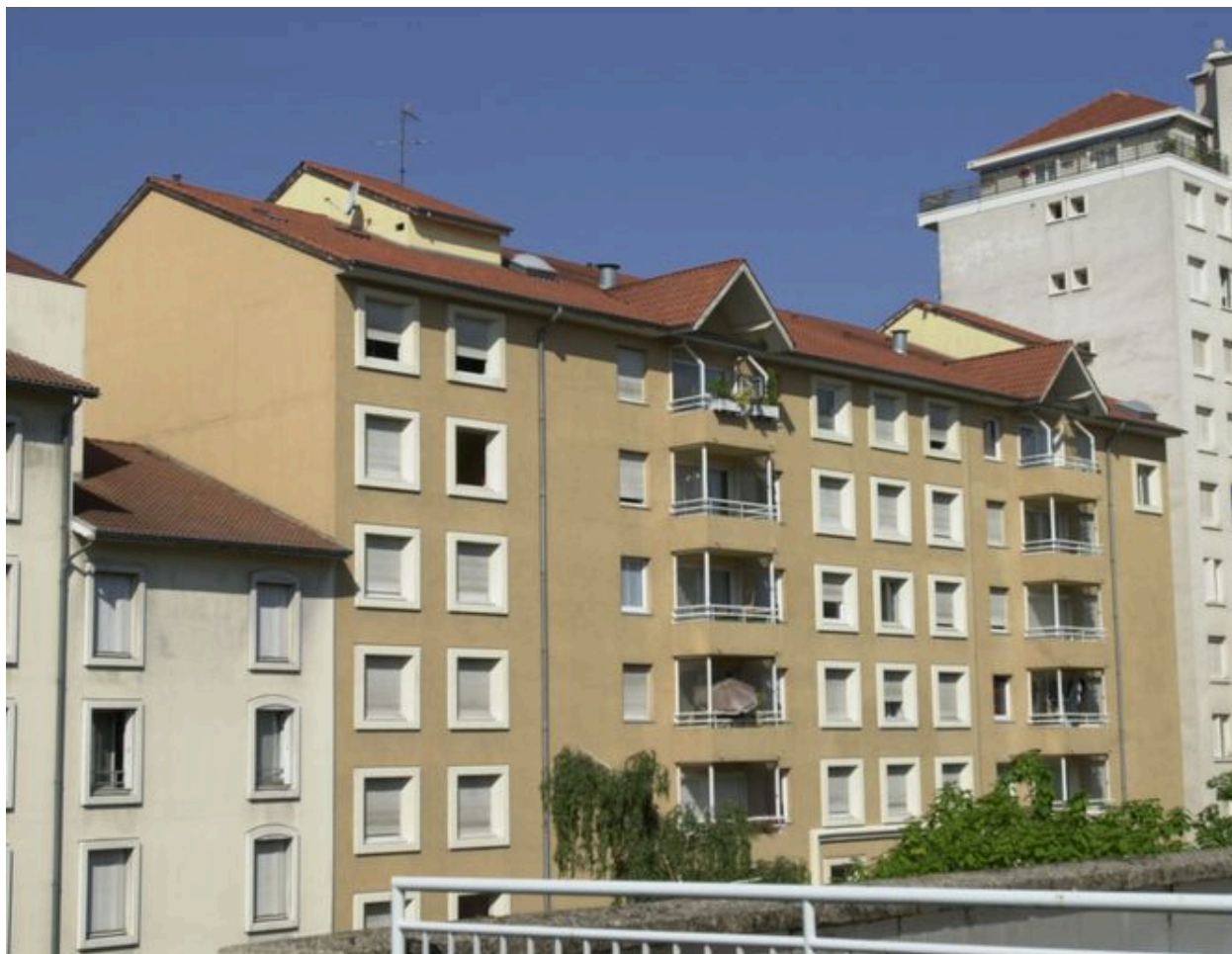
Vue d'ensemble de l'élévation postérieure
