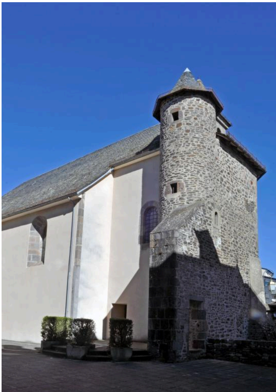
Vue du chevet et tour d'escalier
