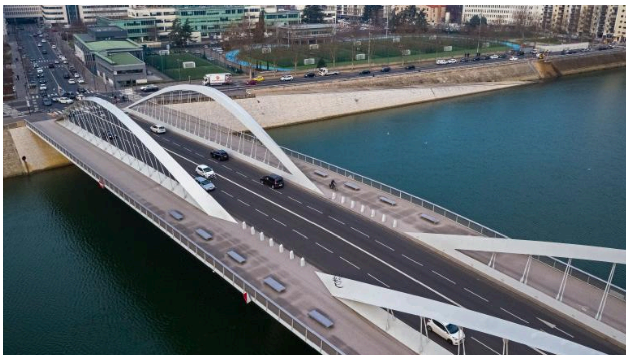
Vue du tablier 4 voies de circulations (drône)
