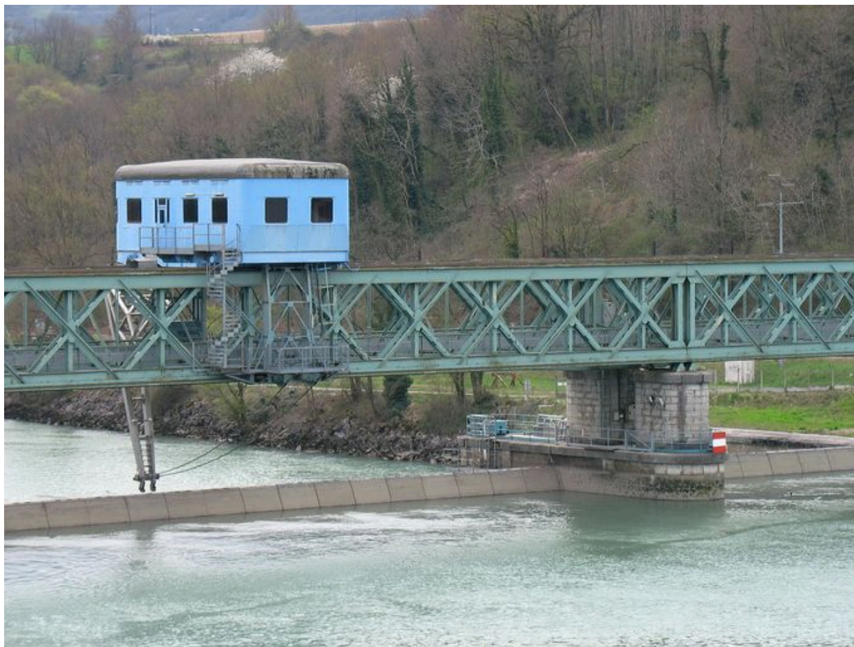
Barrage : vue partielle, face amont (nord)
