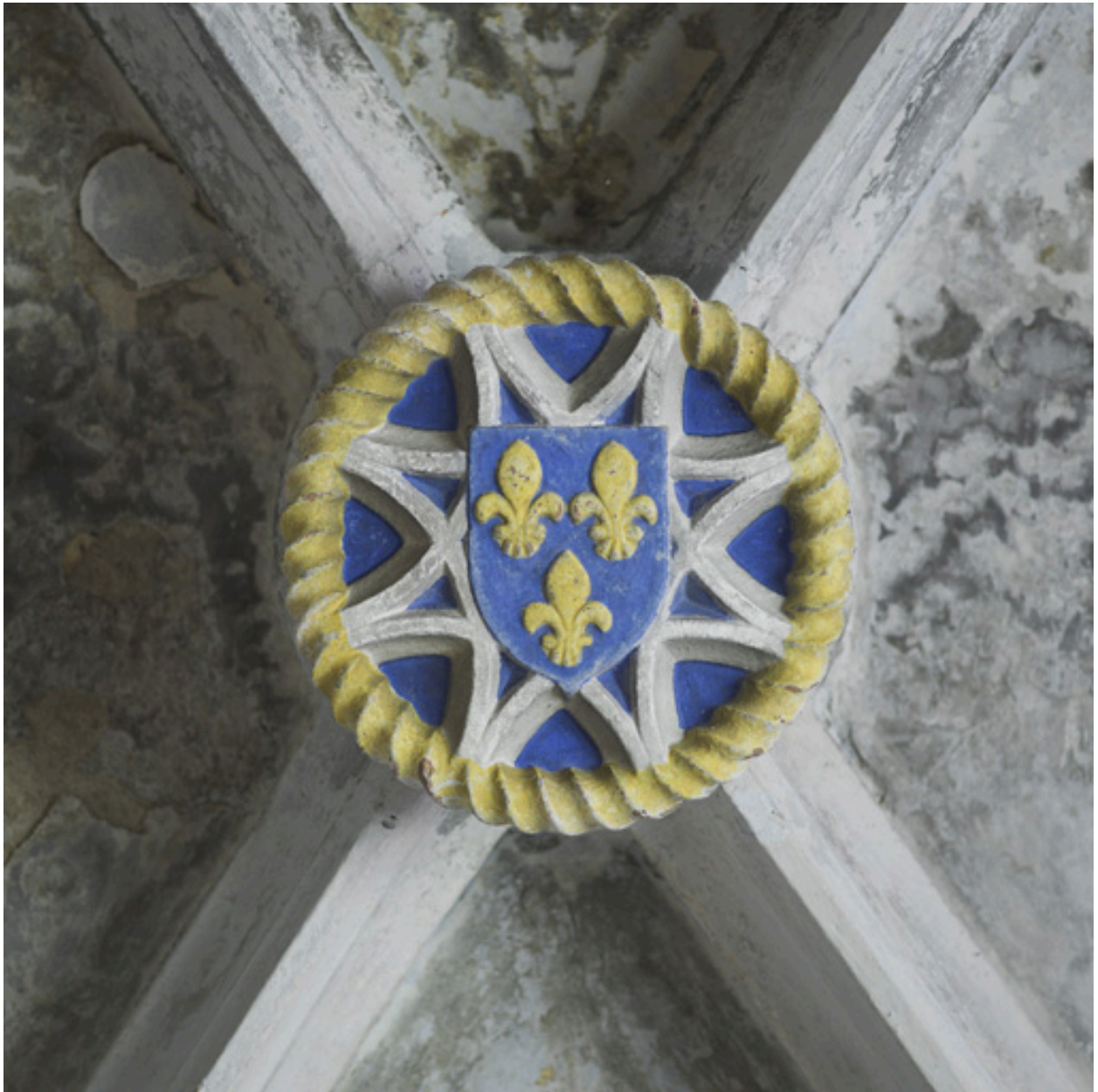
Vue de la clef de voûte n°10.
