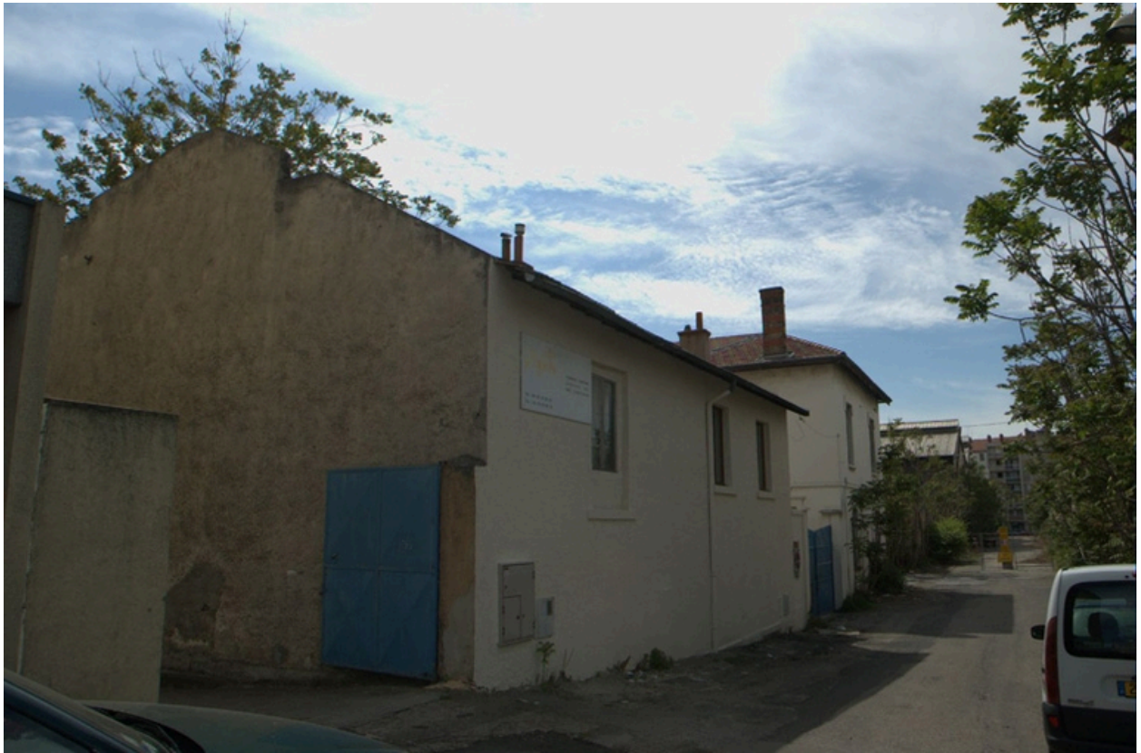
Vue d'ensemble est
