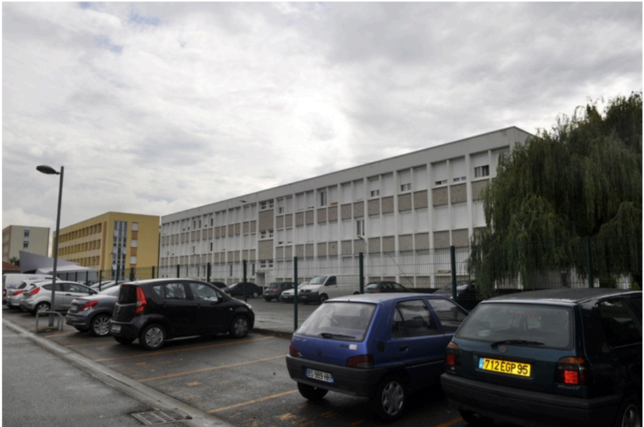
Bâtiment administratif daté des années 50.
