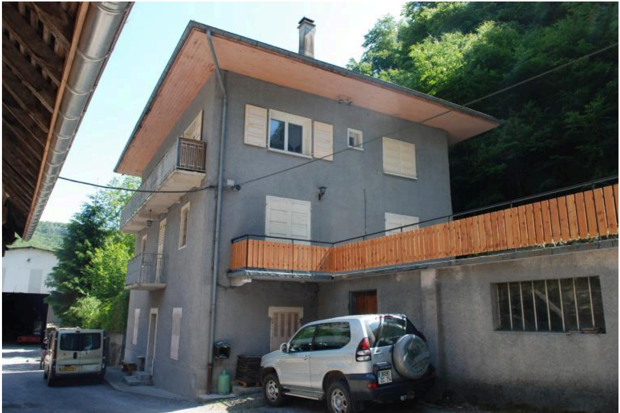
Vue d'ensemble de trois-quarts avant droit de l'habitation.
